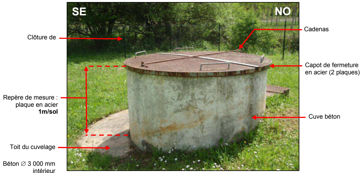
Figure 6 : description de la tête de captage
