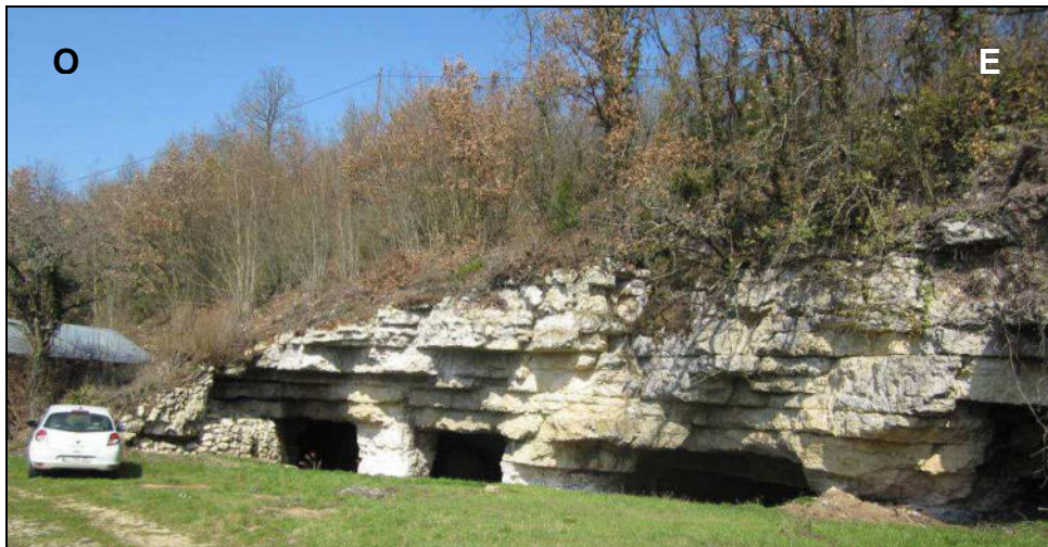
Figure 15 : anciennes carrières souterraines chemin des Pierrières (Chiré-en-Montreuil)
